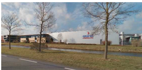
Foto: (hoofd)locatie Eurol aan de Energiestraat 12 in Nijverdal
