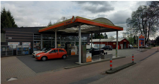
Foto: (LPG) tankstation Olthof aan de Collenstaartweg 7 in Nijverdal
